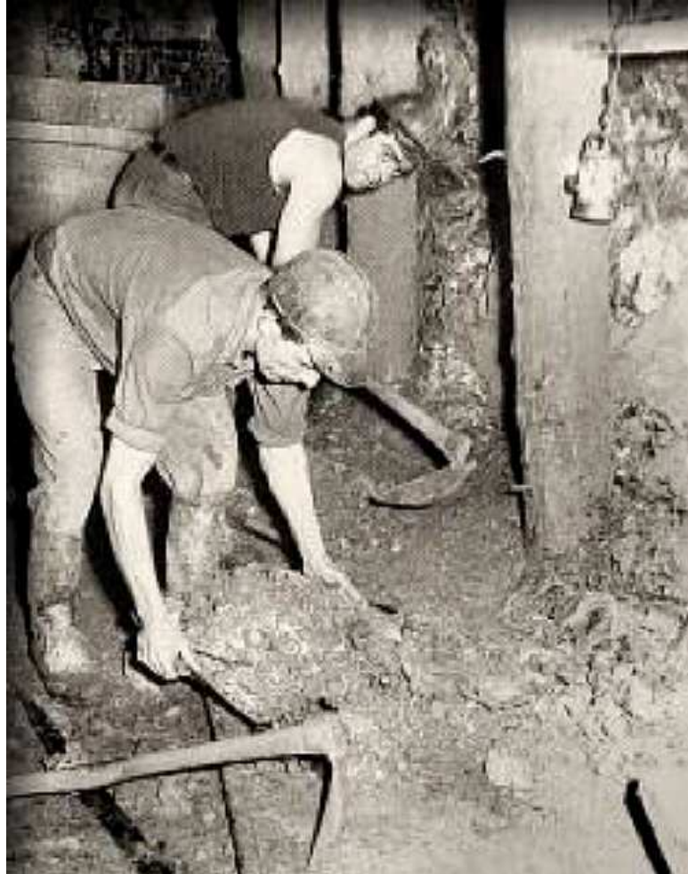
Erzgewinnung mit Kratze und Fülltrog im Harzer Erzbergbau, um 1958. Ganz ähnlich muß man sich die Arbeit im Schaumburger Steinkohlenbergbau vorstellen
