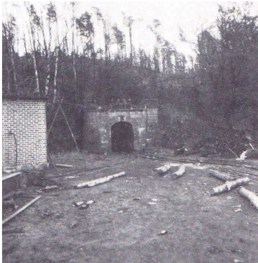
Portal Liethstolln mit vorgelagertem Holzplatz, um 1950
