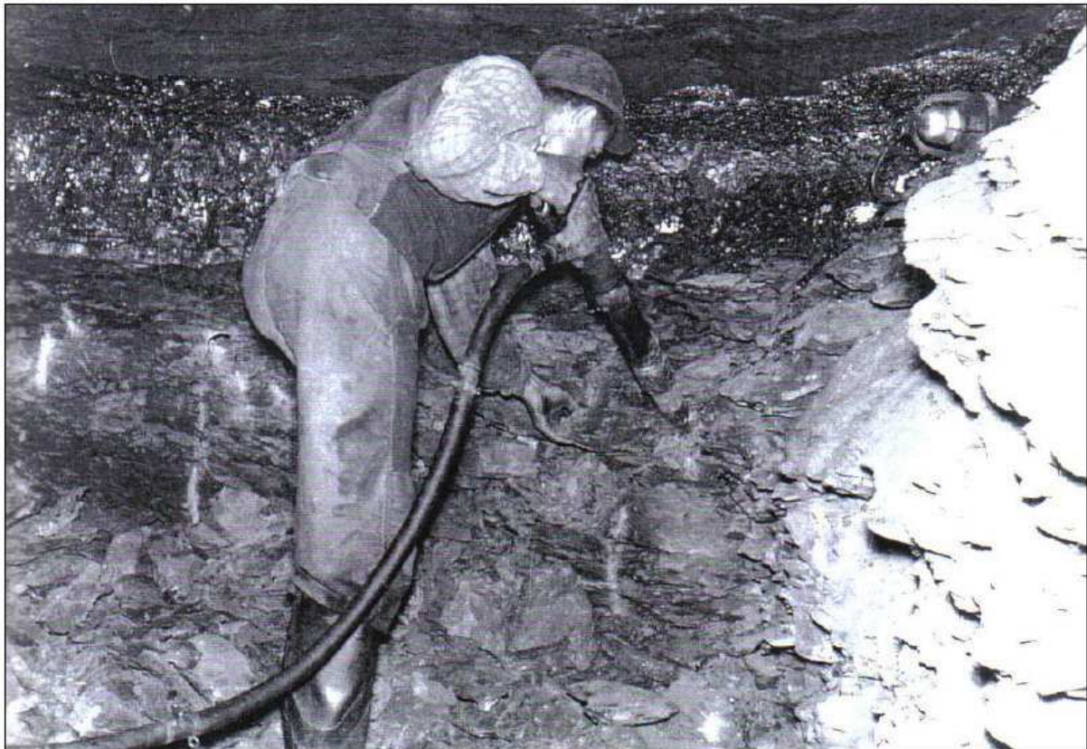
Abb.9 : Abbau des Kohleflözes im Bereich Georgschacht 1 Quelle : Archiv KNICKREHM
