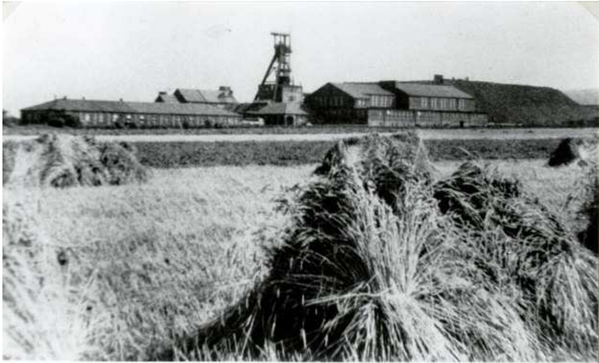
Abb.13 : Doppelschachanlage Beckedorfer Schächte von Lindhorst aus gesehen, ca. 1950
